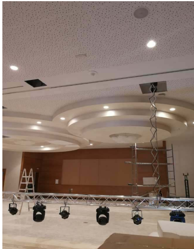
Figure 48 : Antenne salle de conférence
