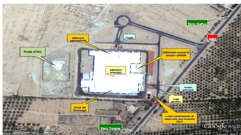
Figure 8 : Aménagement de la société YAZAKI - Gafsa
