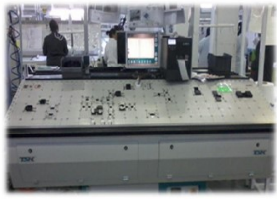
Figure 1.10 : Table de contrôle électrique
