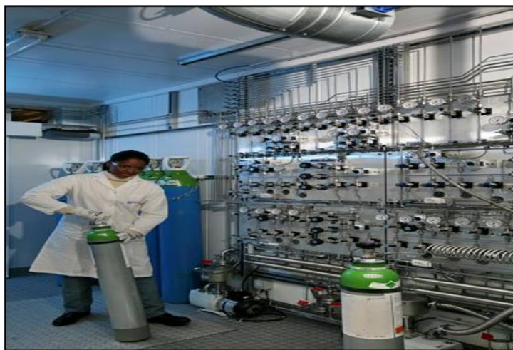
Figure 1.6: Chambre de fabrication des gaz
